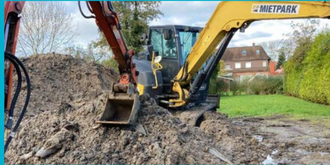
Nachdem die Tiefbauer die Rohrgräben freigelegt haben, ist der Ablauf der Arbeiten wie folgt: Die zwei Rohrleitungen für den Vor- und Rücklauf werden entlang der Straße und zu den Hausanschlüssen verlegt. Nach dem Verschweißen der einzelnen Rohrabschnitte erfolgt noch die Isolierung der Verbindungen. Anschließend werden die Gräben wieder verfüllt und die Wege und Höfe werden gepflastert, um ihren ursprünglichen Zustand wiederherzustellen.
